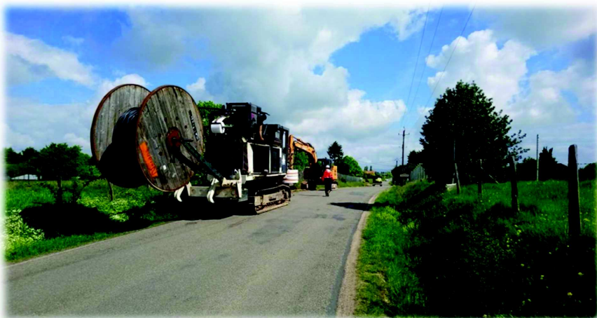
Exemple de chantier d'enfouissement de câble le long d'une voirie (source : sciepdd)
