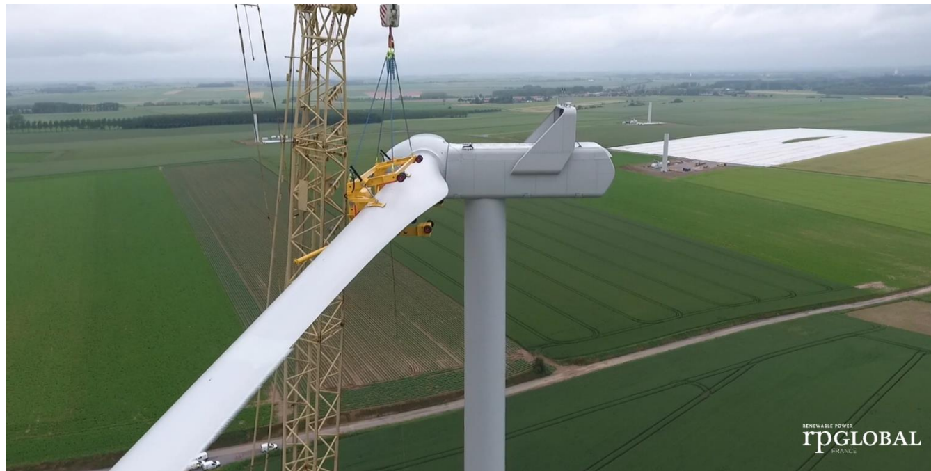
Figure 101 : Montage et assemblage des pales
