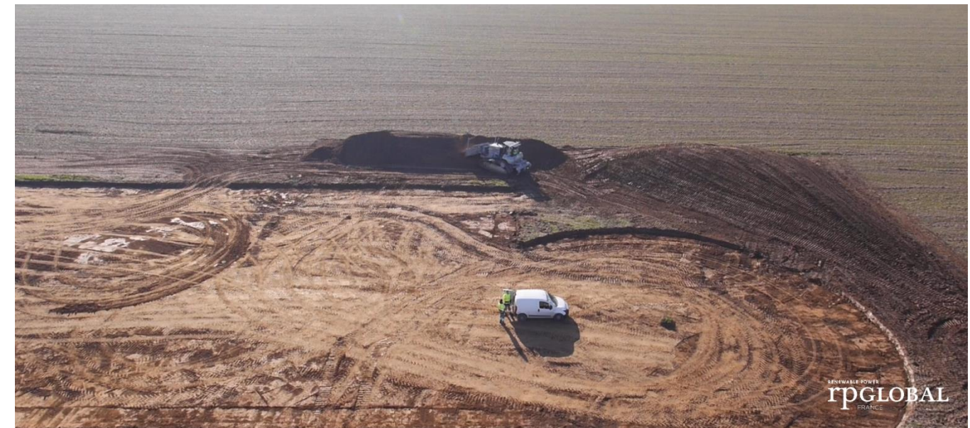
Figure 97 : Préparation du terrain
