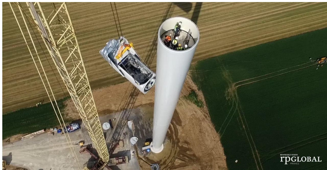
Figure 99 : Assemblage de la nacelle
