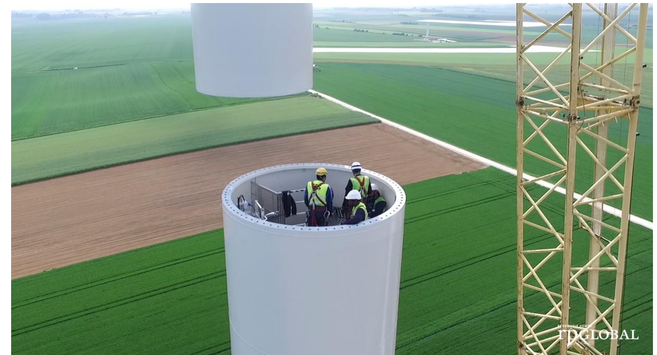
Figure 91 : Assemblage d'une section de tour
