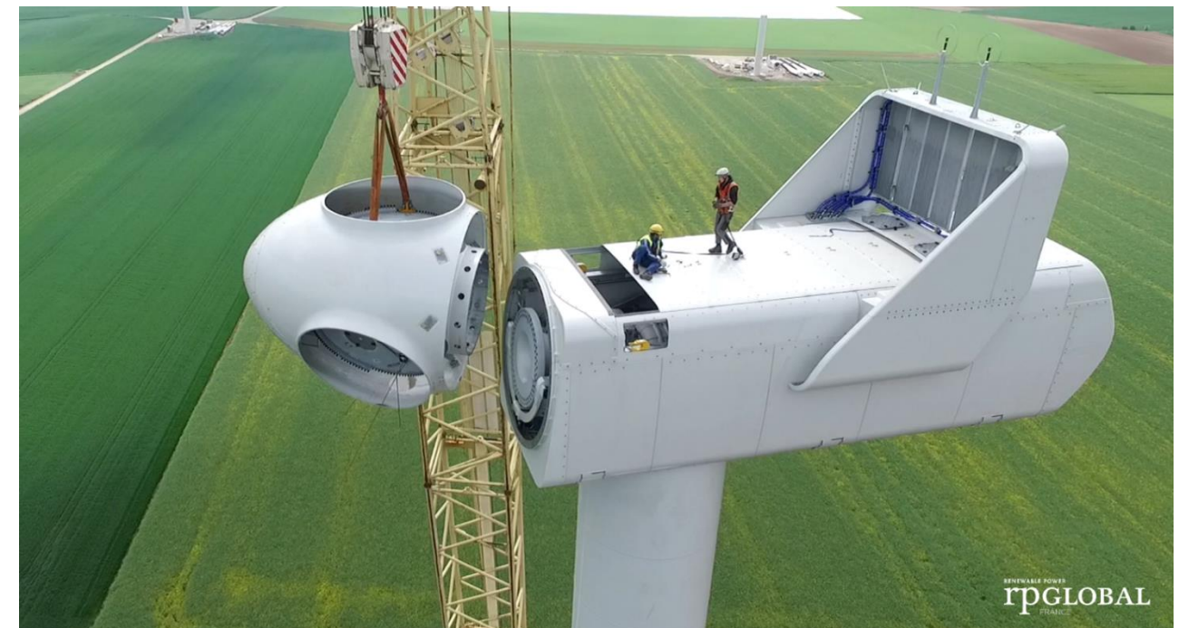
Figure 100 : Montage et assemblage du moyeu
