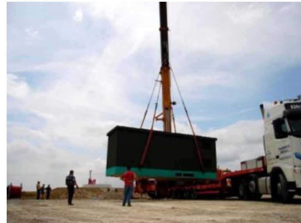
Figure 93 : Pose d'un poste de livraison
