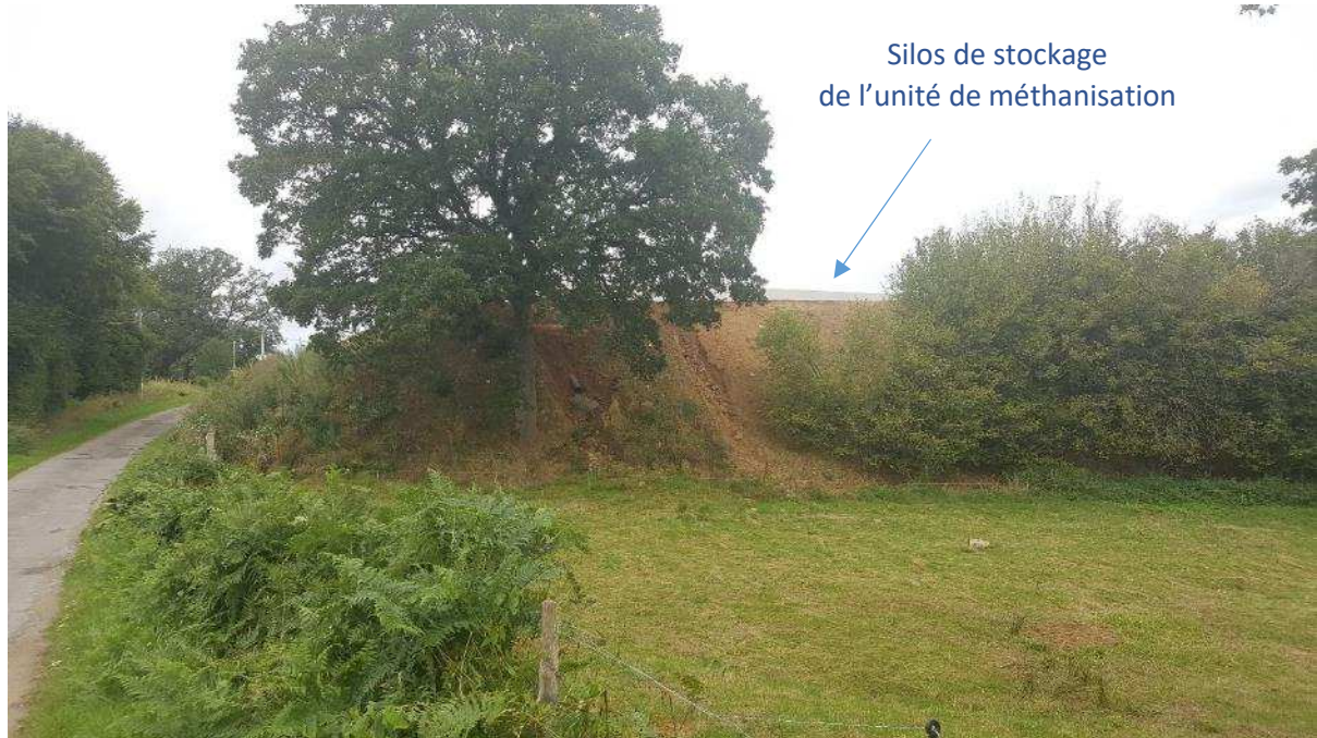
Vue depuis la route communale menant à l'habitation de Beauséjour
