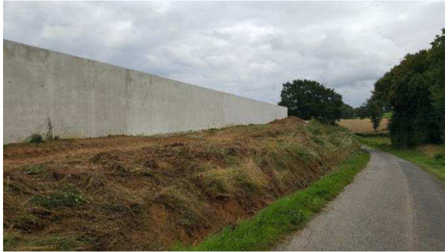
Fossé de récupération des eaux pluviales le long de la route communale
