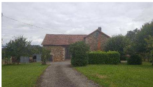
Habitation à 110 m à l'est du site lieu-dit « Beauséjour »
