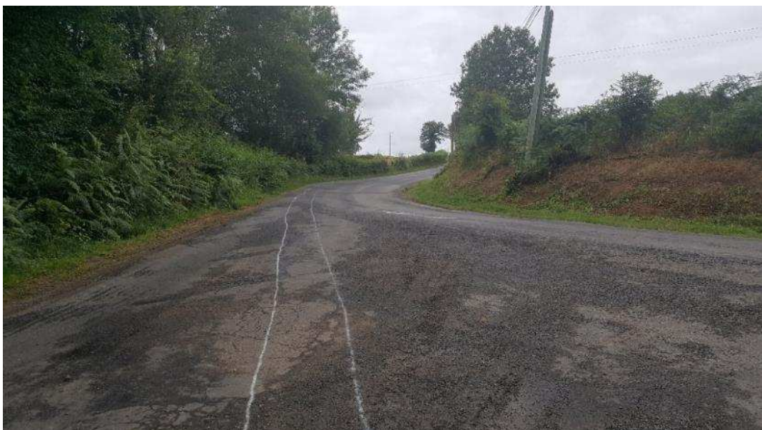
Marquages au sol de la canalisation de gaz avant travaux
