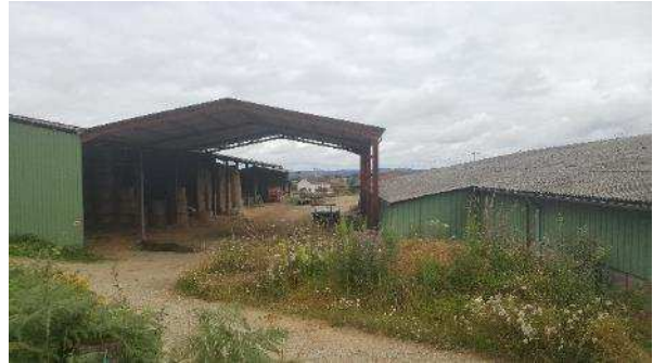
Installations agricoles (préexistantes) de l'EARL VINCENT
