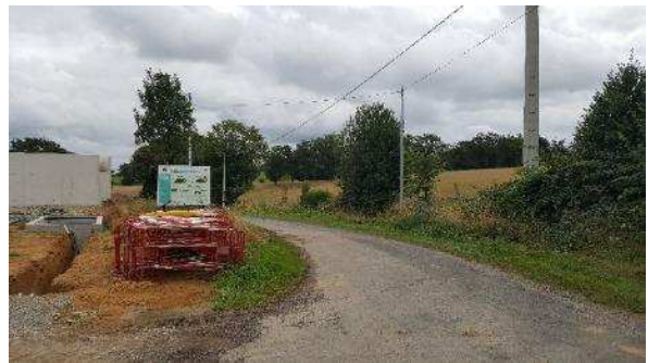
Vue depuis l'accès au site sur la route de Leycure Pero en direction de l'est
