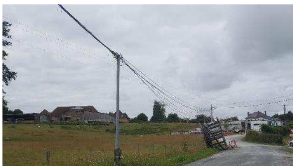
Habitation à 690 m à l'ouest lieu-dit d'Engarenne
