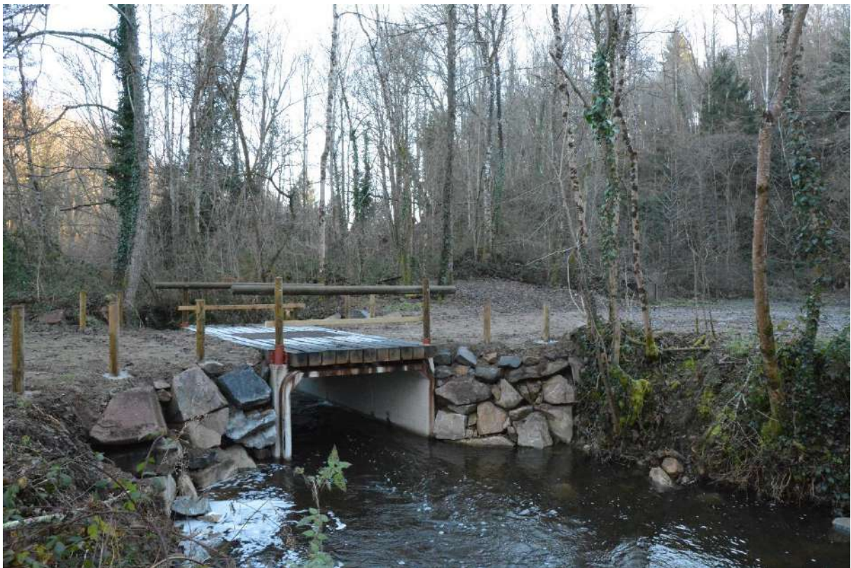
Figure 15 : Illustration d'une passerelle (la Valoine, en aval du Moulin de la Vergne à Feytiat)
