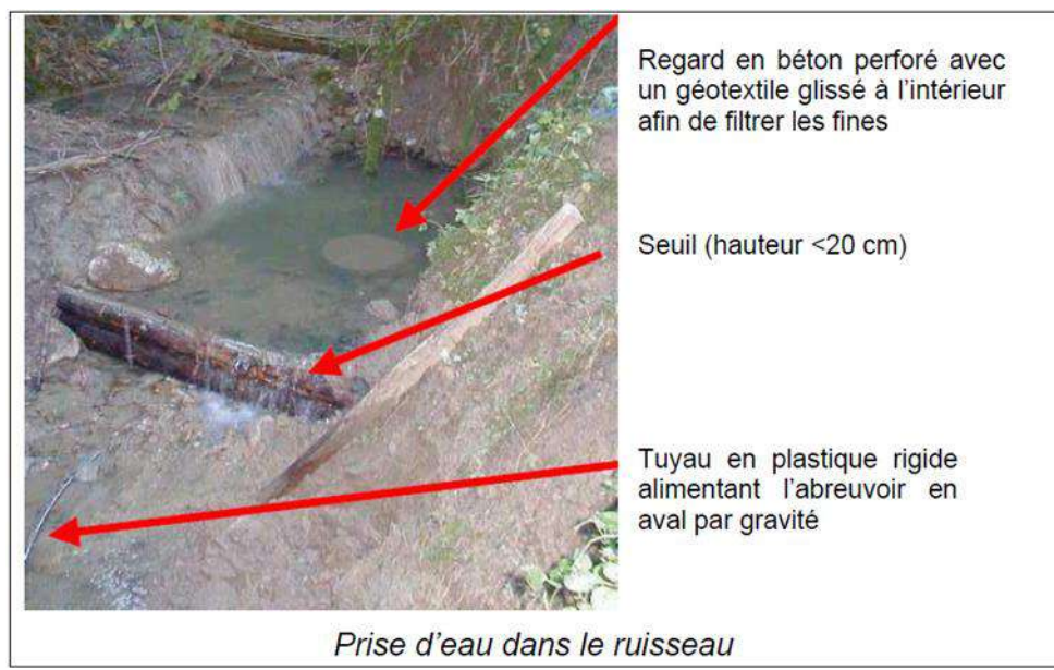
Figure 6 : Illustration d'une prise d'eau en ruisseau pour l'aménagement de buses d'abreuvement à niveau constant
