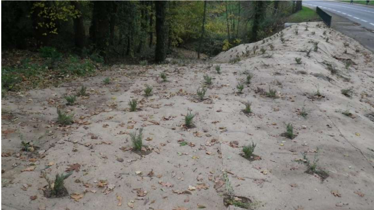
Figure 18 : Illustration d'une zone traitée par géotextile et plantations
