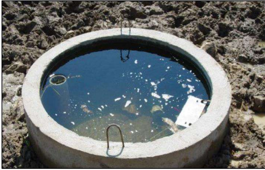
Figure 7 : Illustration d'une buse d'abreuvement à niveau constant
