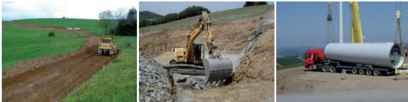
Photographie 150 : Illustration d'un chantier éolien
