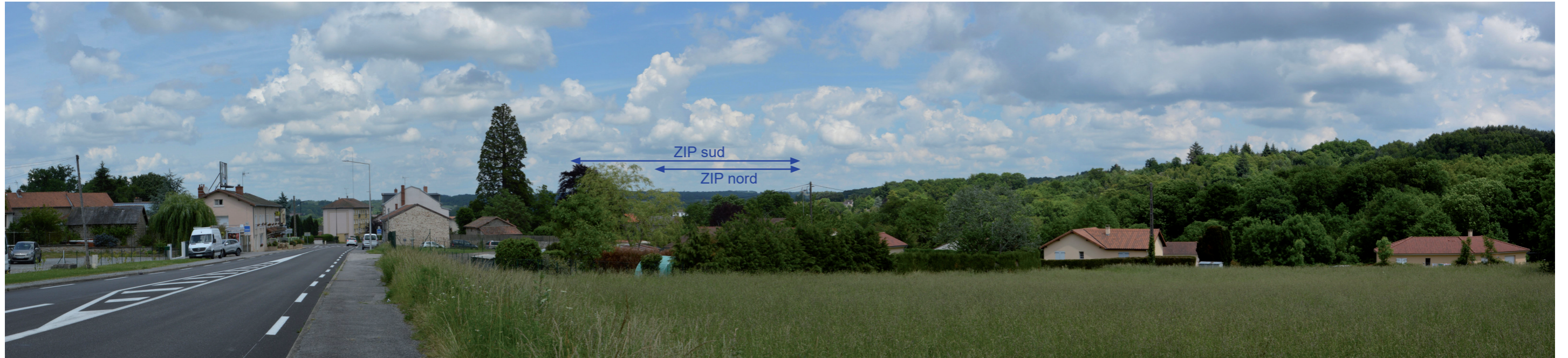
Photographie 39 : Vue sur la ZIP depuis la D220, au sud de Bessines-sur-Gartempe, à 5,5 km
