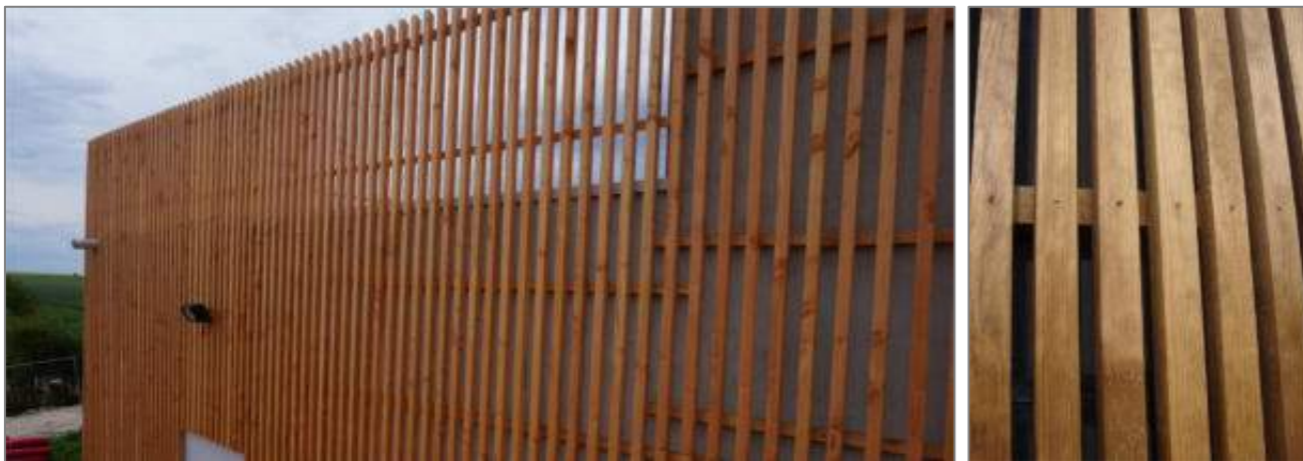
Photographie 65 : Exemple de bardage bois à claire-voie vertical garantissant l'intégration paysagère du poste de livraison tout en évitant l'installation des chiroptères attirés par le confinement.
