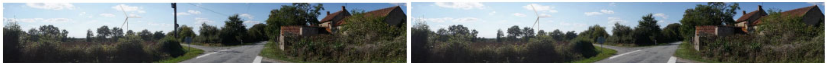
Figure 8 : vue du carrefour du Point du Jour sans et avec enfouissement des réseaux aériens
