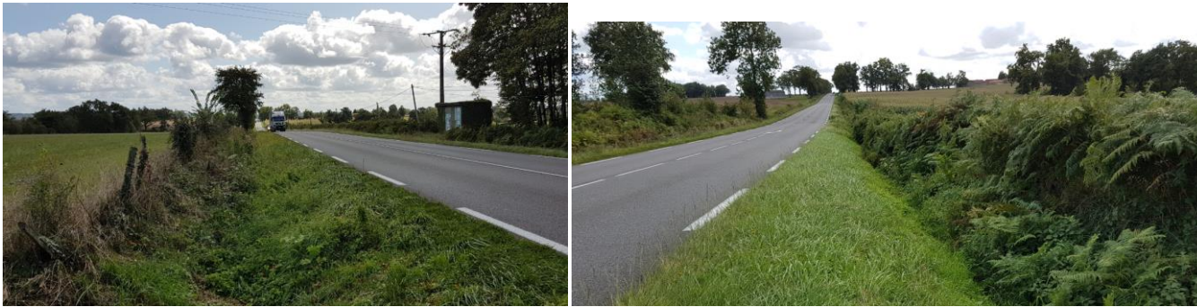
Photo 2 : Fossés présents sur la section Chamborêt
