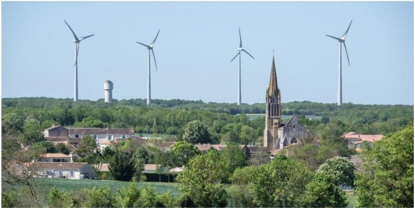
À Bignay, en Charente-Maritime, les éoliennes font partie du paysage. © Crédit photo : Archives Xavier Léoty/"Sud Ouest"
