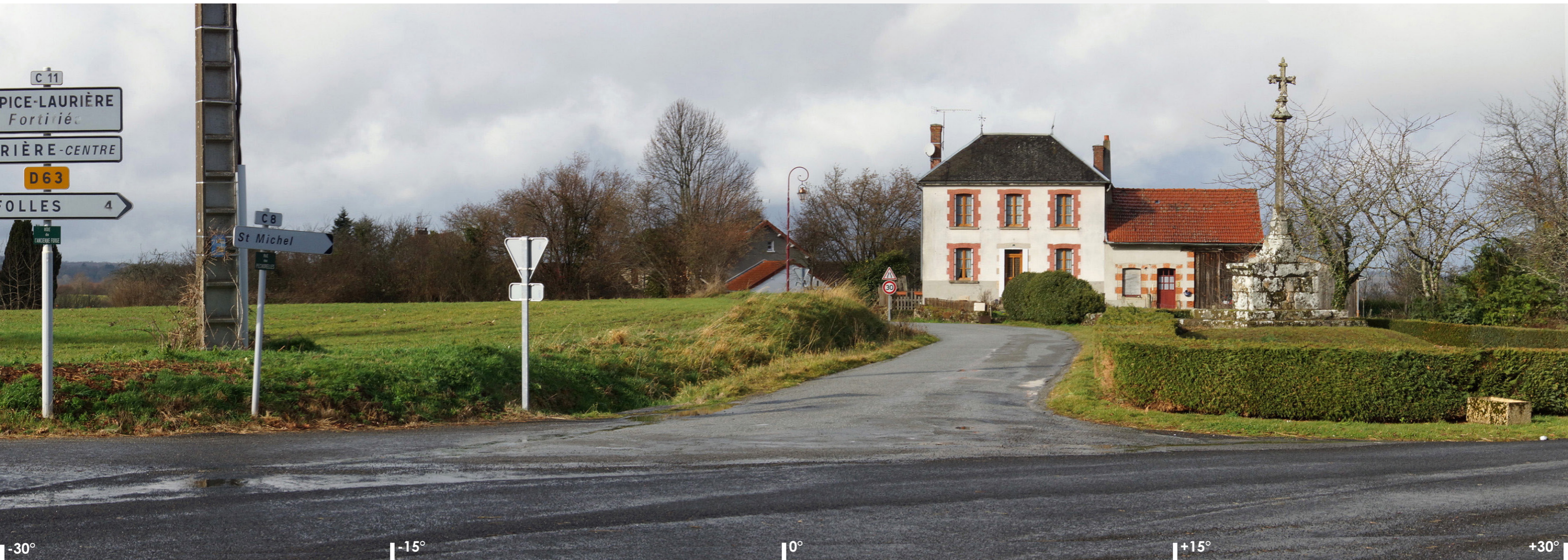
Montage 60° - éoliennes renforcées
