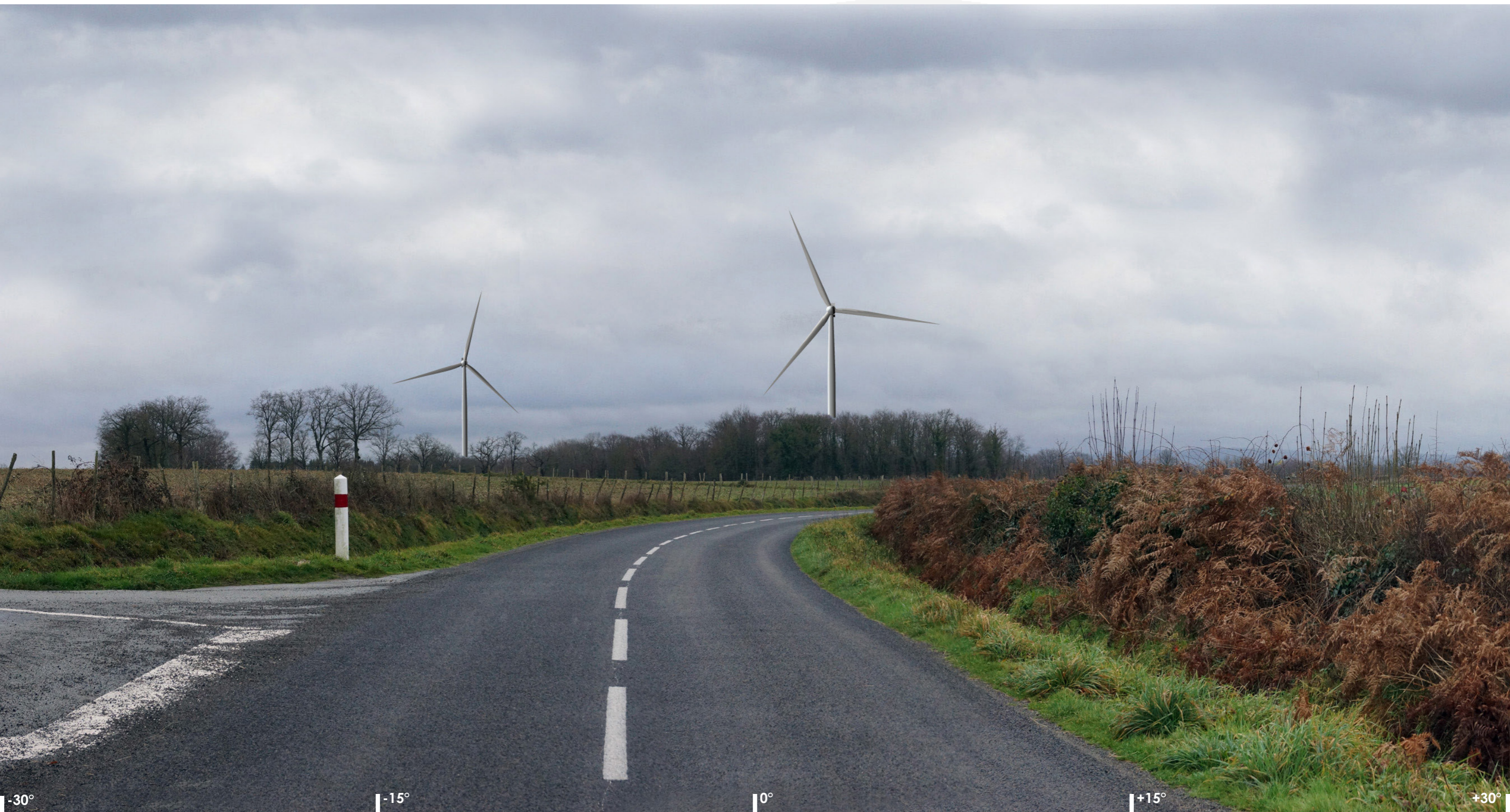
Montage 60° - éoliennes renforcées
