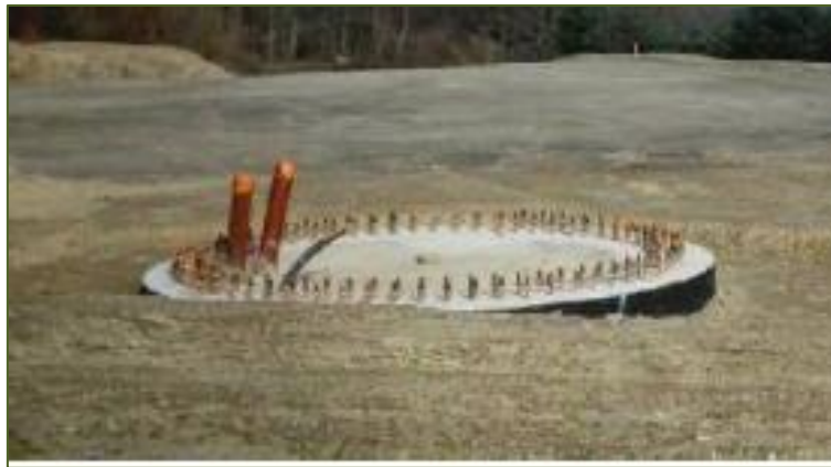
Photographie 8 – Fondation d'éolienne une fois remblayée (source : Siemens Gamesa)
