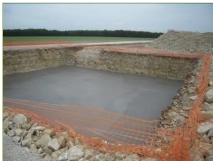
Photographie 3 – Béton de propreté (source : Siemens Gamesa)
