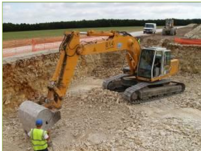
Photographie 2 – Excavation (source : Siemens Gamesa)
