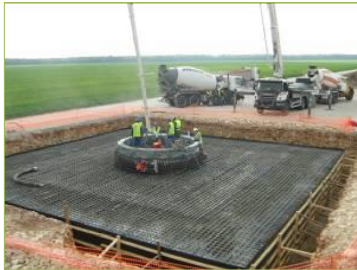
Photographie 4 – Ferrailage supérieur et bétonnage (source : Siemens Gamesa)
