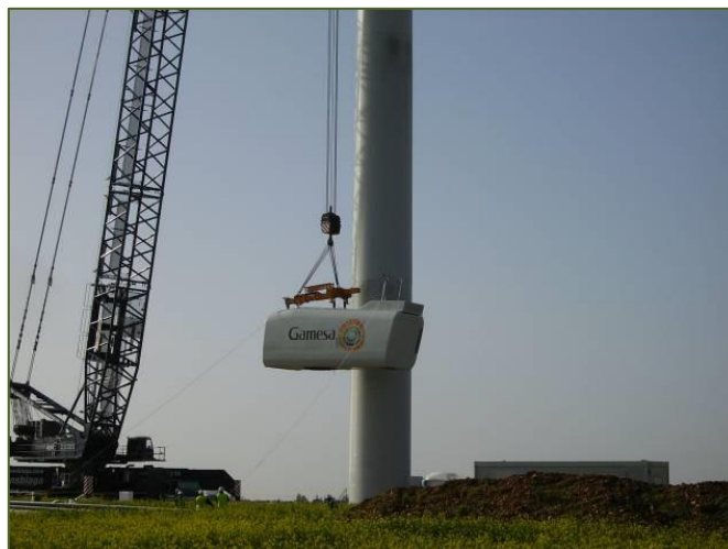
Photographie 7 - Montage de la nacelle (source : Siemens Gamesa)
