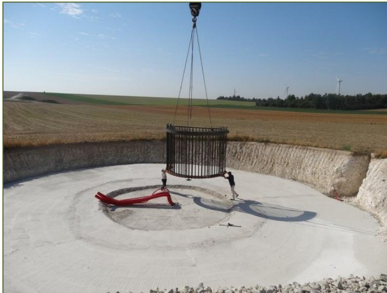
Photographie 9 – Exemple de mise en place d’une fondation (source : Siemens Gamesa)
