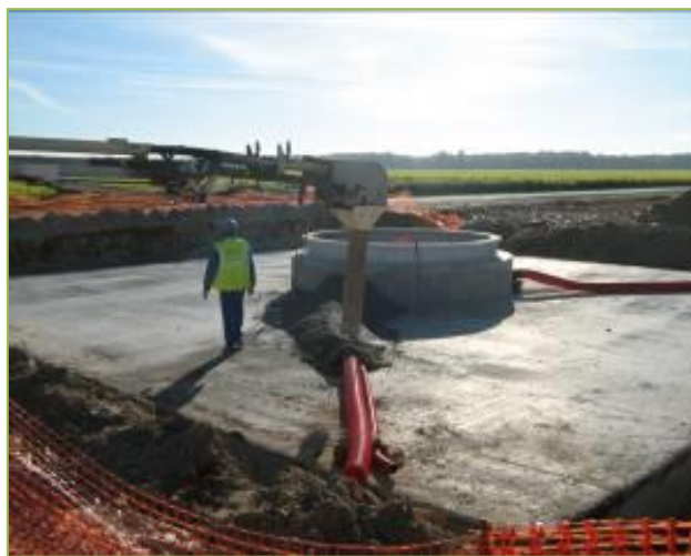
Photographie 5 – Coffrage de la cage d’ancrage et des câbles (source : Siemens Gamesa)
