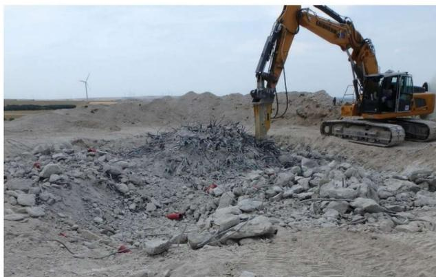
Démantèlement intégral des fondations d'une éolienne dans la Marne (Source: QUADRAN)
