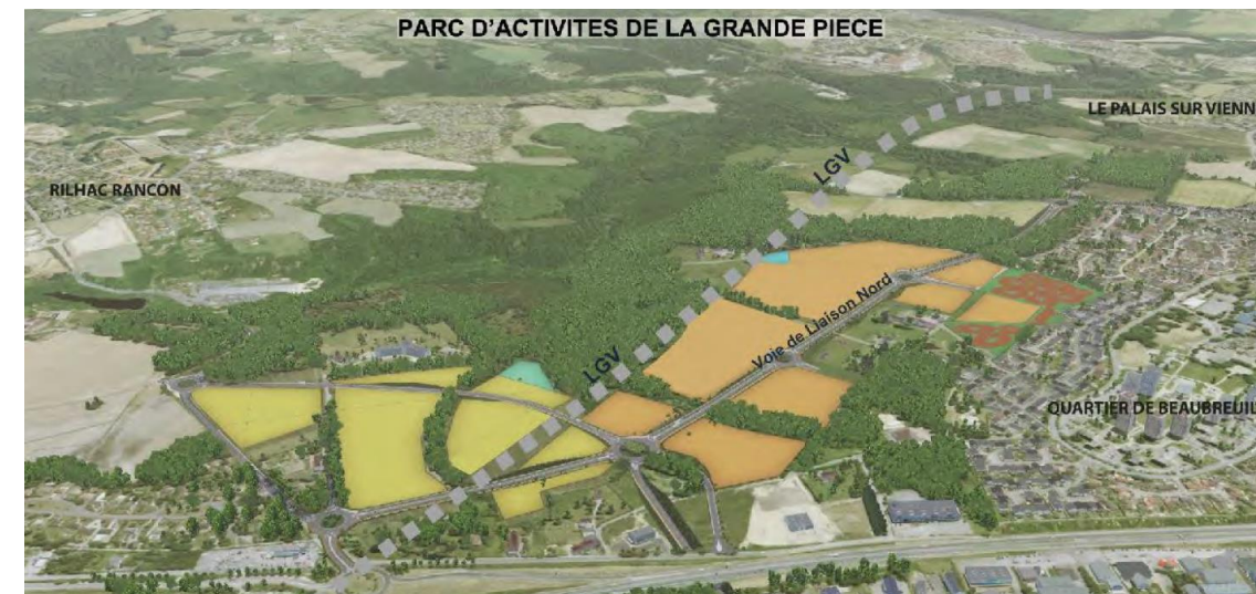
Figure 38: Localisation du futur parc d'activités de la Grande Pièce (Source : Dossier de concertation préalable à l'aménagement du parc d'activités)
