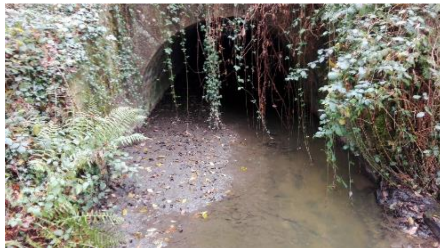
Ouvrage de franchissement de la LGV en amont de l'étang
