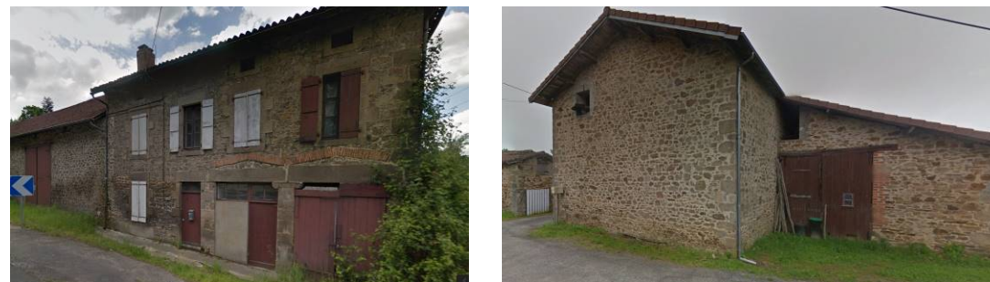
Vieux bâtis favorables aux chauves-souris aux lieux-dits La Poitevine (Nieul, à gauche) et Lavaud (Couzeix, à droite) (source : google street view)
