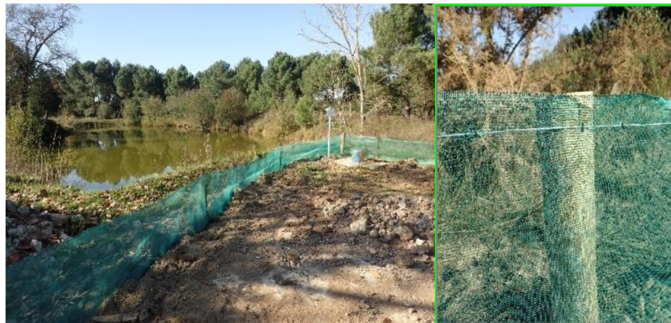
Figure 101 : Filet temporaire grillagé en tissu synthétique vert mis en place dans le cadre de mesures environnementales en Charente-Maritime, filet enterré, pose mécanique (BKM, 2017)
