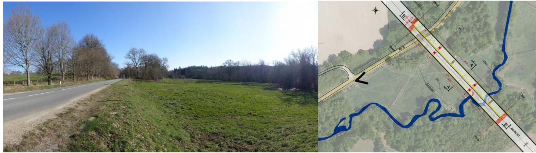
Figure 115 : Vue de l'existant (à gauche) Point de vue sur le viaduc de la Glane depuis la RD28 (à droite)
