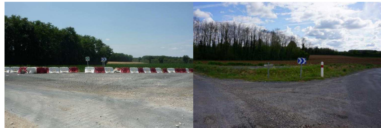
Photographies 32 et 33 : Exemple de réduction de l'emprise d'un virage pour une piste d'accès sur un parc éolien.
