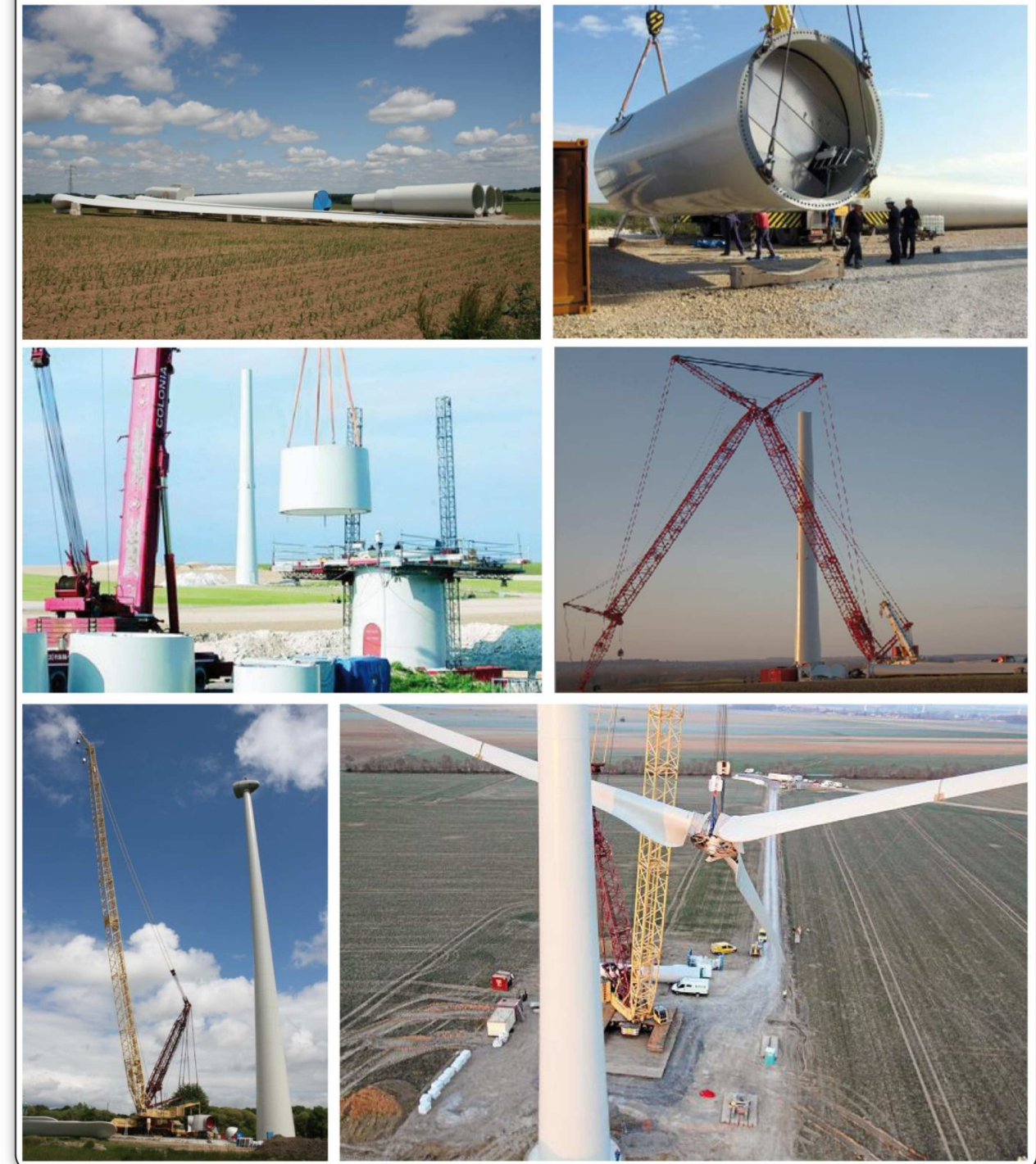
Montage d'une éolienne
