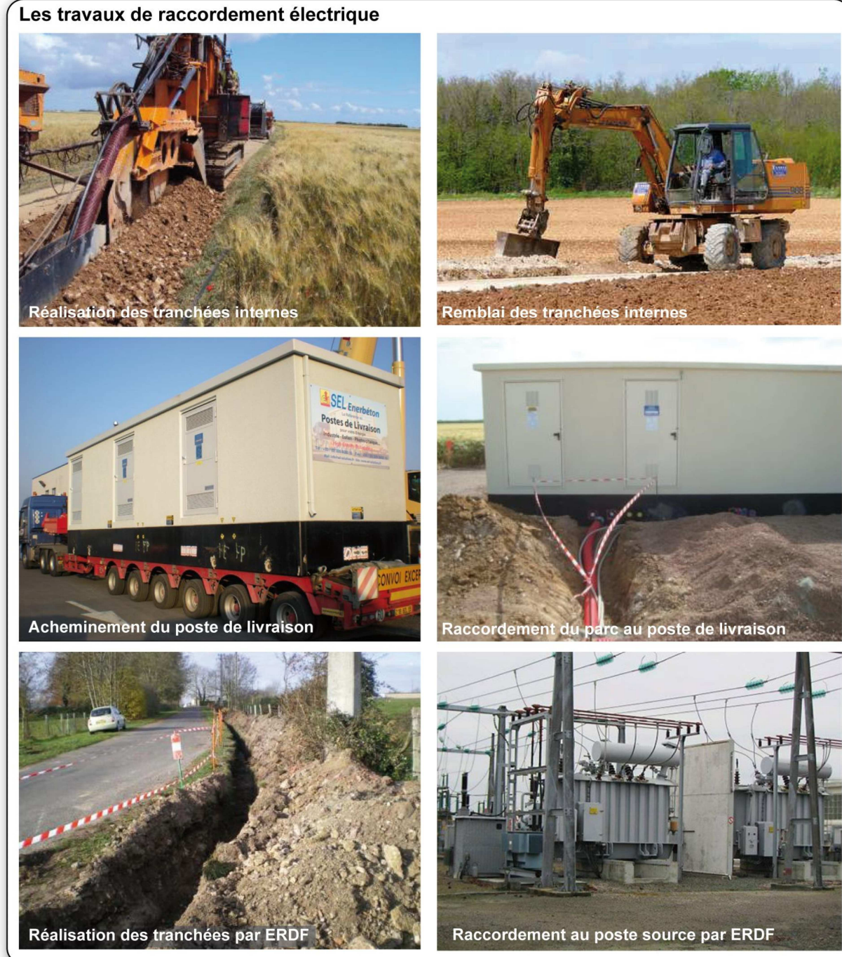
Photographie 20 : Travaux de raccordement électrique
