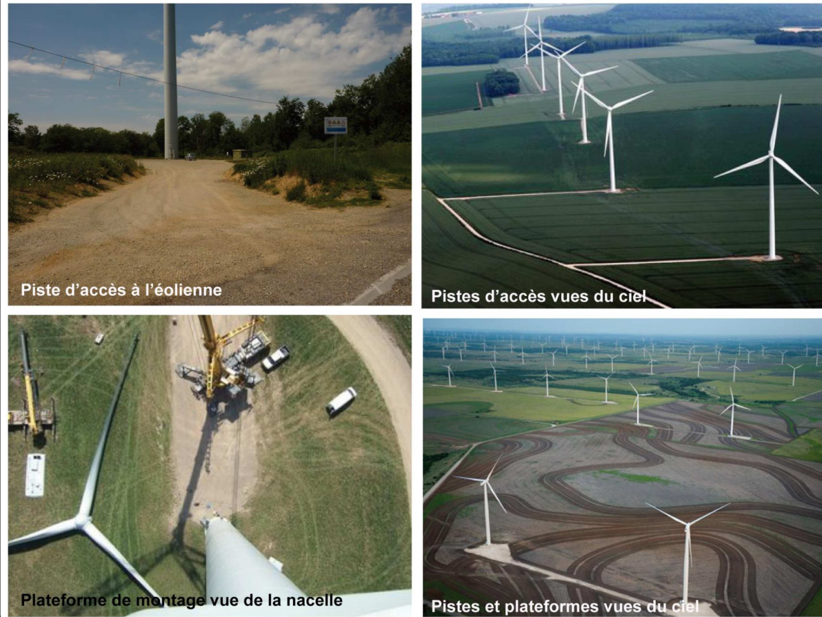
Photographie 17 : Exemples de plateformes de montage et de pistes
