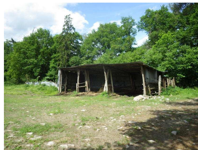
Photographie 12 : Bâtiment agricole présent sur la ZIP (source : ENCIS Environnement)
