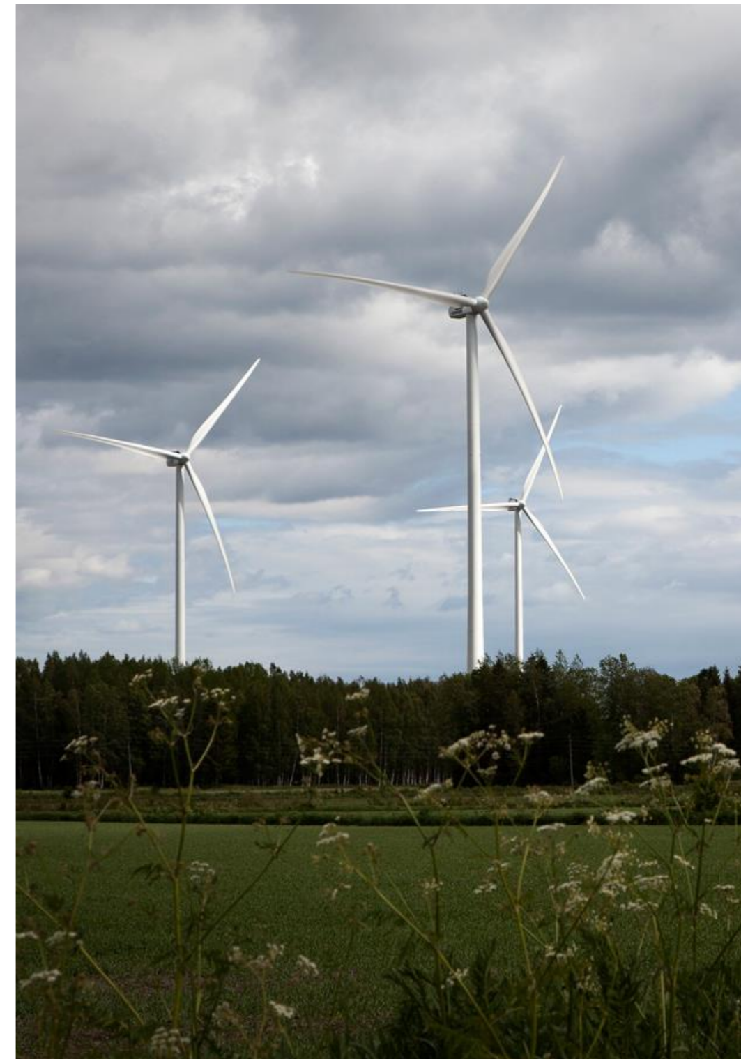
Exemple d'éolienne VESTAS V126
