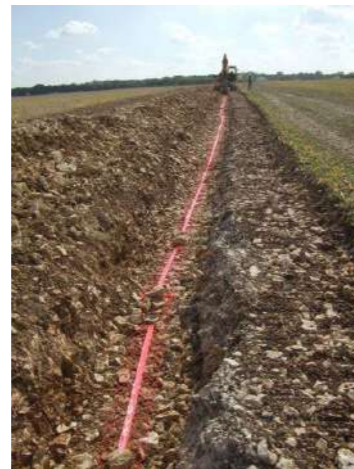
Figure 5 : Pose d'un grillage avertisseur en plastique rouge au-dessus du câble (Source : wpd)
