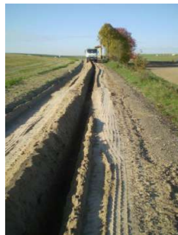
Figure 6 : Réalisation d'une tranchée dans un chemin d'exploitation agricole (Source : wpd)
