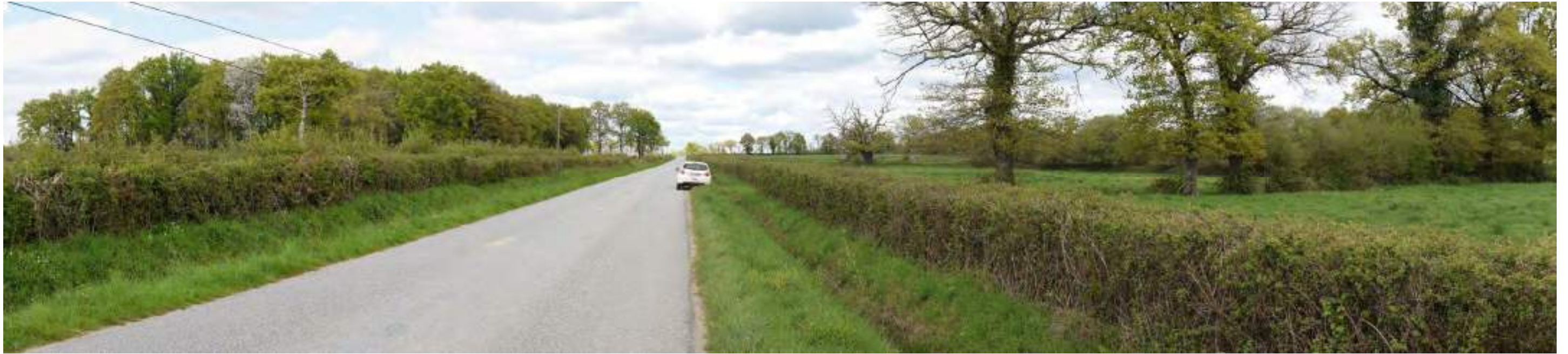
Photographie 52 : La D 7 immédiatement au sud de l'AEIm
