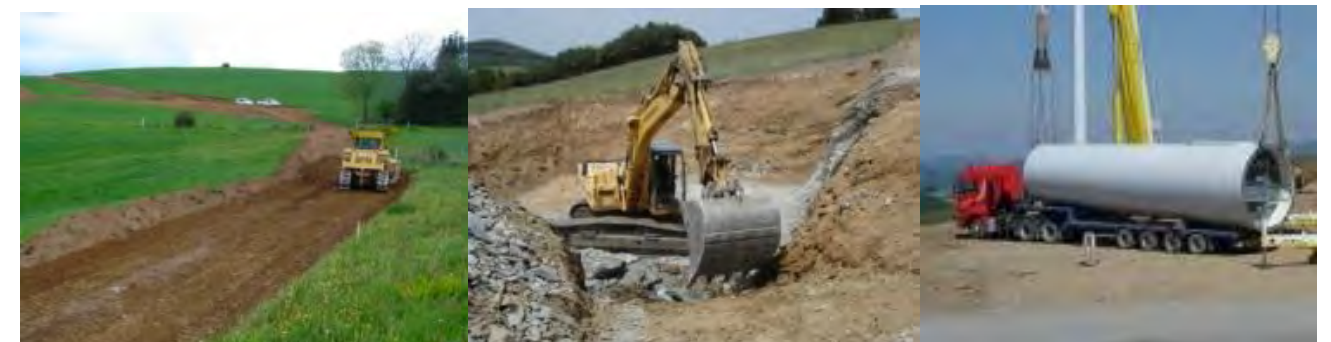
Photographie 69 : Illustration d'un chantier éolien
