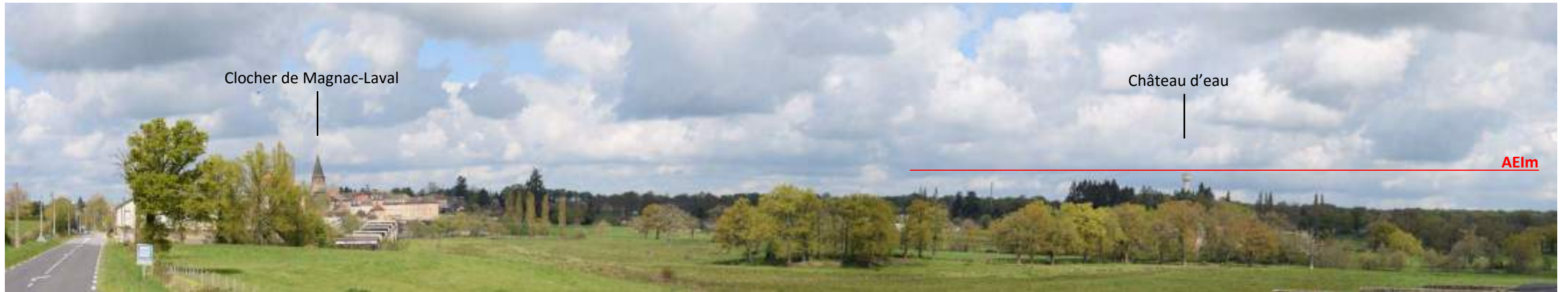
Photographie 56 : Covisibilité entre le clocher de l'Eglise Saint Maximin et l'AEIm, depuis la D 942 à l'entrée est du bourg (angle visuel du panoramique 100° environ)
