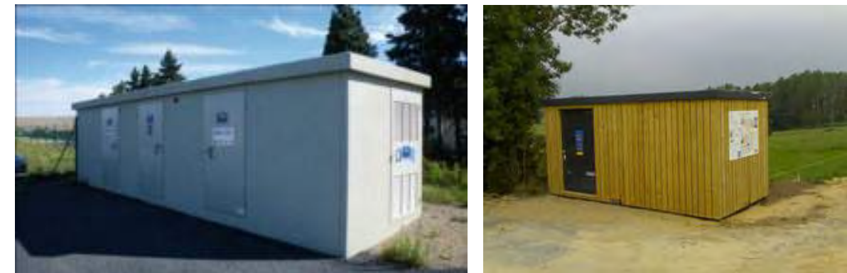
Photographie 71 : Exemple de poste de livraison "brut" et habillé d'un bardage bois
