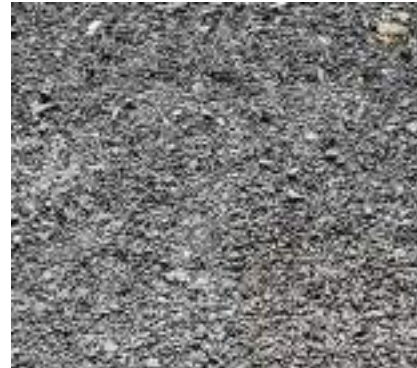
Photographie 66 : Exemple de texture des pistes en concassé granit
