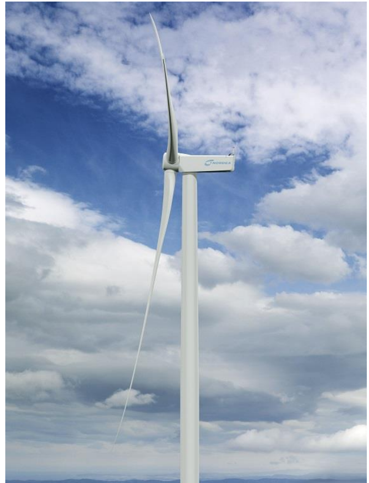
Exemple d'éolienne N131
