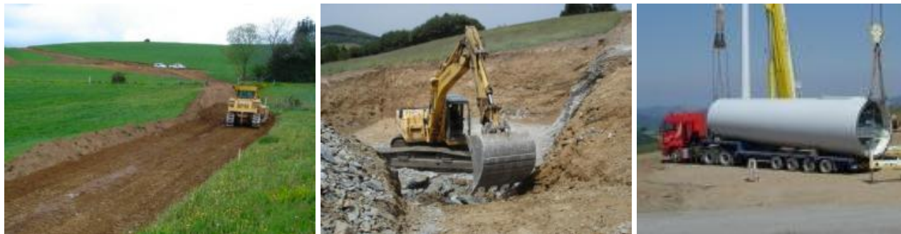
Photographie 4 : Illustration d'un chantier éolien
