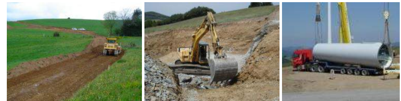
Photographie 33 : Illustration d'un chantier éolien
