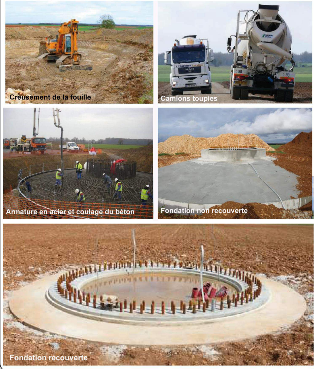
Photographie 25 : Etapes de réalisation d'une fondation d'éolienne
