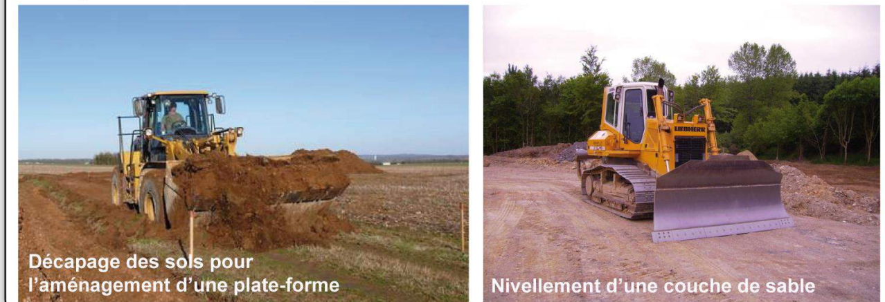
Photographie 24 : Exemples d'engins de travaux de VRD
