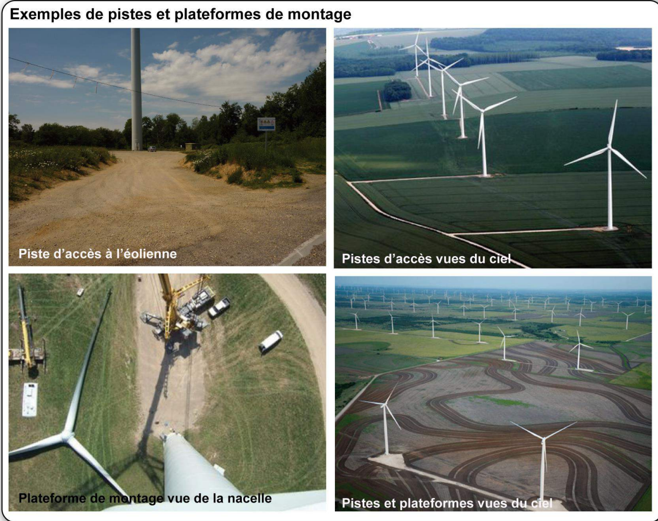
Photographie 22 : Exemples de plateformes de montage et de pistes
