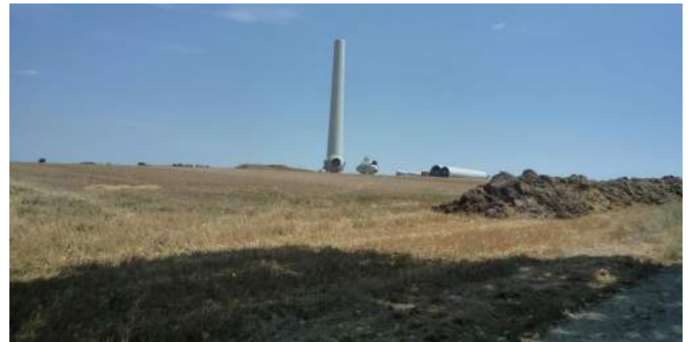
Photographie 29 : Exemple de stockage de terre durant un chantier éolien
