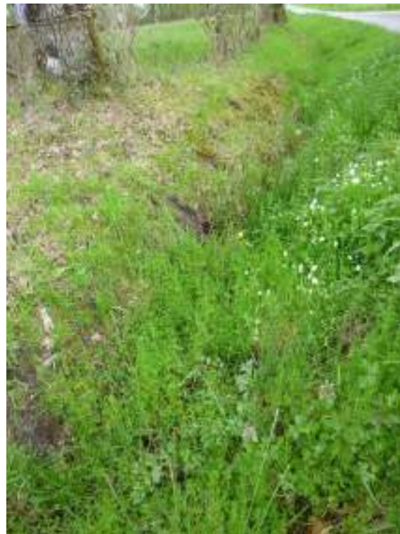
Photographie 4 : Fossé (Source : ENCIS Environnement)
