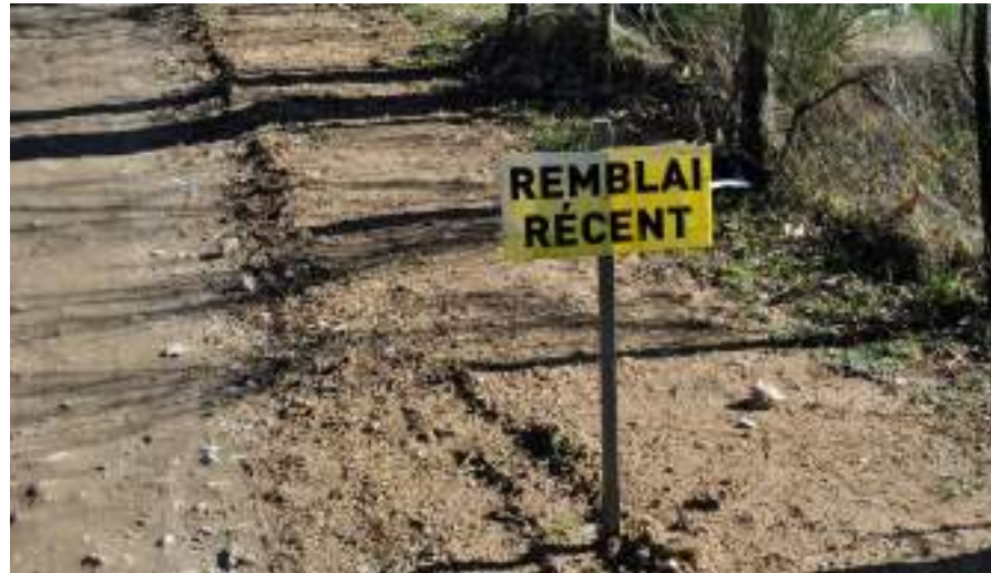
Photographie 30 : Exemple de remblai des tranchées électriques le long d'une piste
