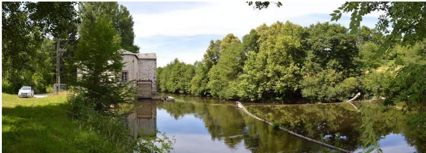
Photographie 14 : Vue du moulin du Quéroux sur les bords de la Gartempe
