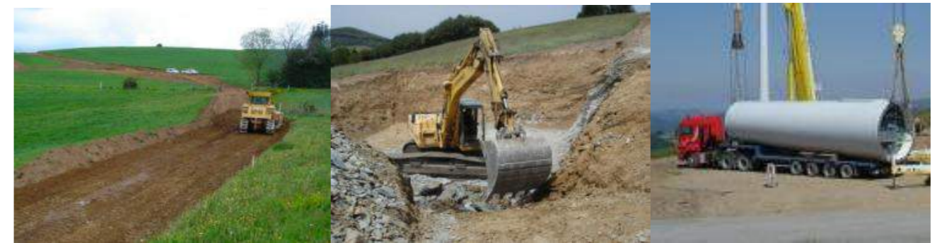
Photographie 105 : illustration d'un chantier éolien
