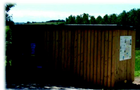
Exemple d'un poste de livraison bardé de bois
