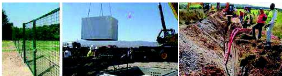
Illustration 71 : Exemple de chantier d'un parc photovoltaïque au sol
