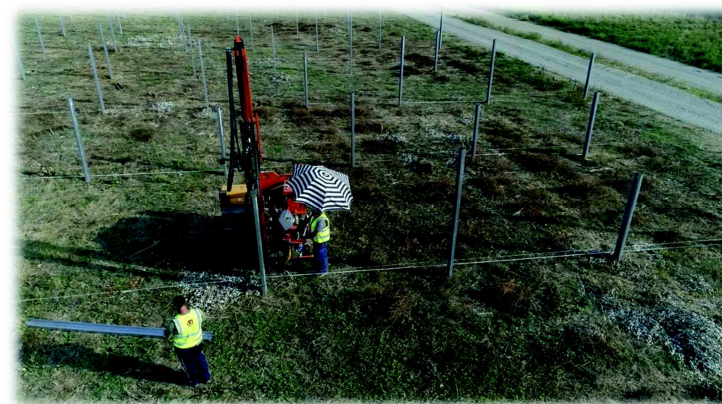
Exemple d'un chantier de battage de pieux pour parc photovoltaïque au sol (source : https://www.dronesudtoulouse.fr/ )
