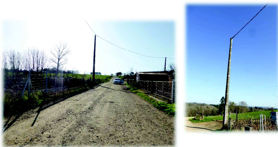
Ligne BT aérienne en limite de l'AEI (@ECTARE)
