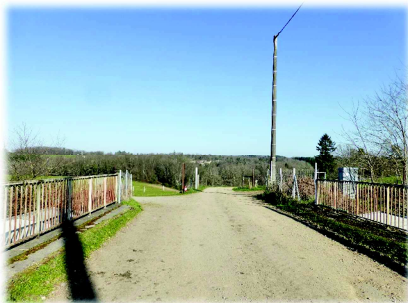
Entrée du site depuis le pont franchissant la voie ferrée
