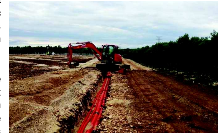
Exemple d'enfouissement de câbles électriques
