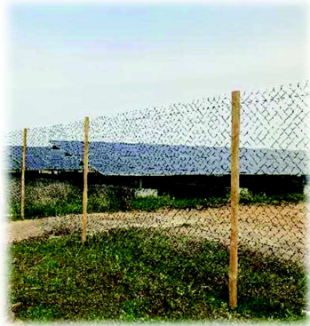
Exemple de clôture bois
