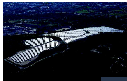
Parc solaire Gardanne (13) – Foncier communal Développement, Financement, Construction et Exploitation Ancien terril de mine/Site BASIAS
