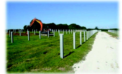
Exemple de voie d'accès en matériaux concassés
