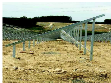
Exemple d'une structure porteuse complète avant mise en place des panneaux
