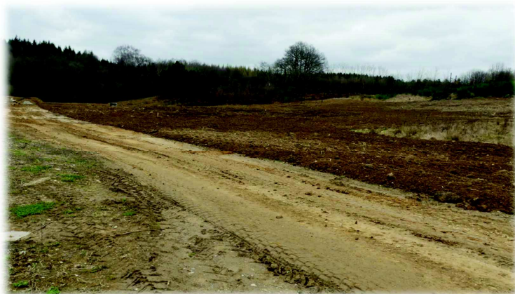
Parcelles remblayées et recouvertes de terre au sein de l'AEI
