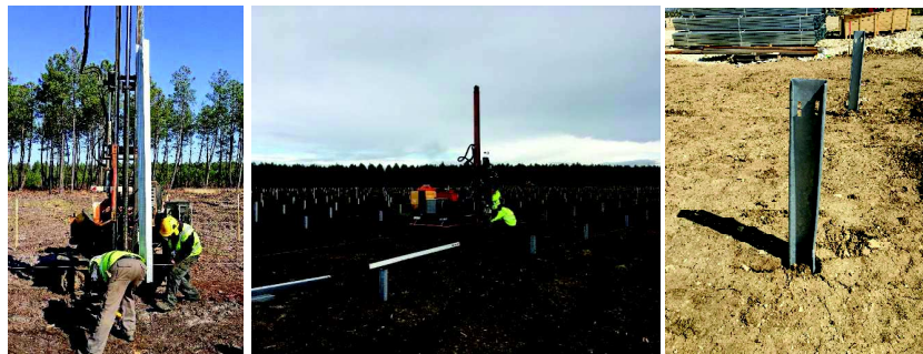
Exemples de mise en place des pieux sur les chantiers URBASOLAR
