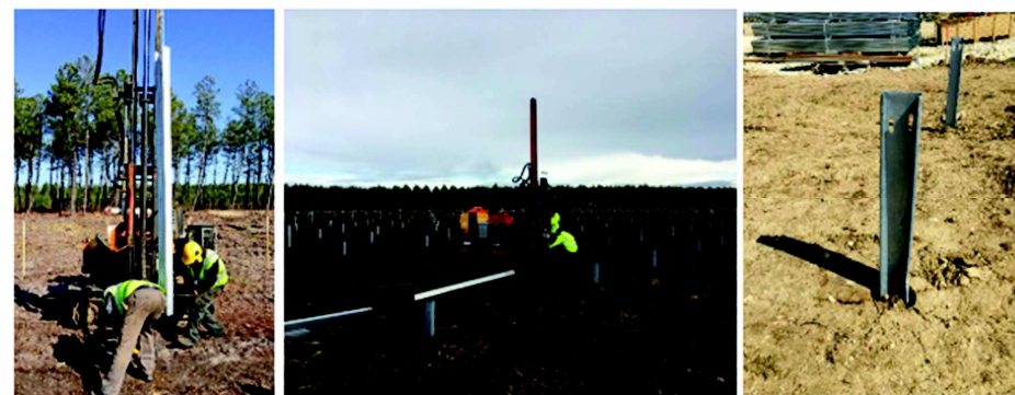
Illustration 2 - Exemples de mise en place des pieux sur les chantiers URBASOLAR
