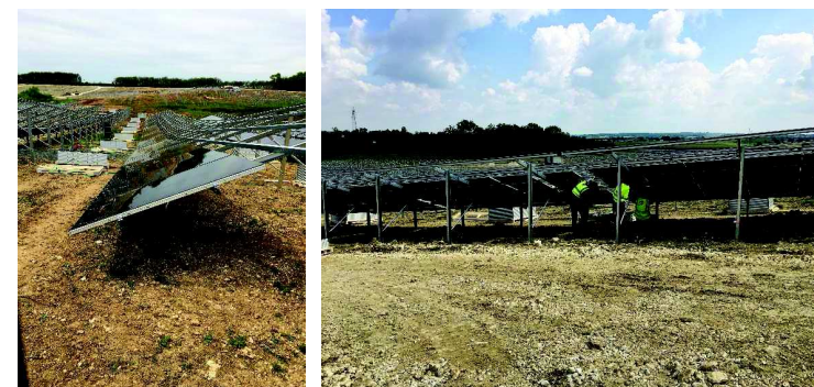
Exemples de mise en place de panneaux sur les chantiers URBASOLAR
