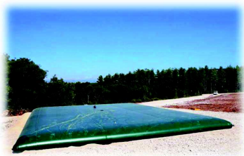
Photographie d'une citerne en cours de mise en place sur un projet
