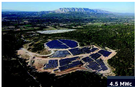
Parc solaire Fuveau (13) – Foncier privé Développement, Financement, Construction et Exploitation Ancien terril de mine/Site ICPE
