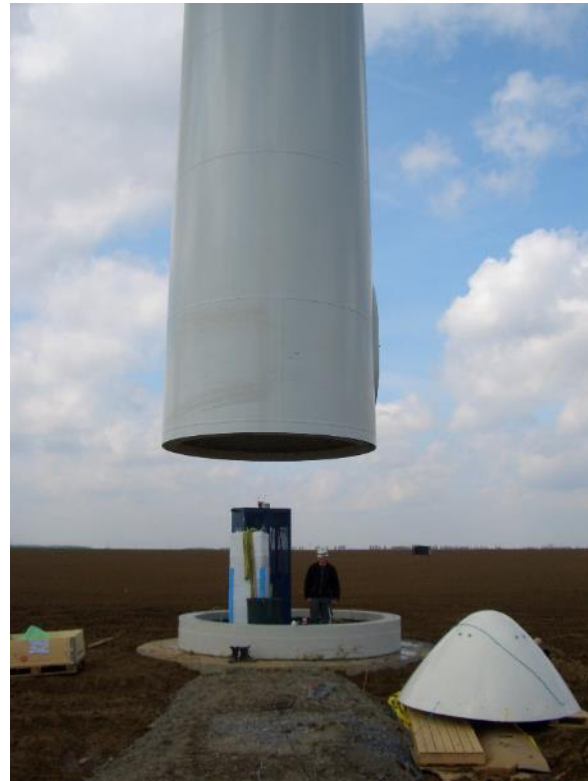
Montage de la base du mât
