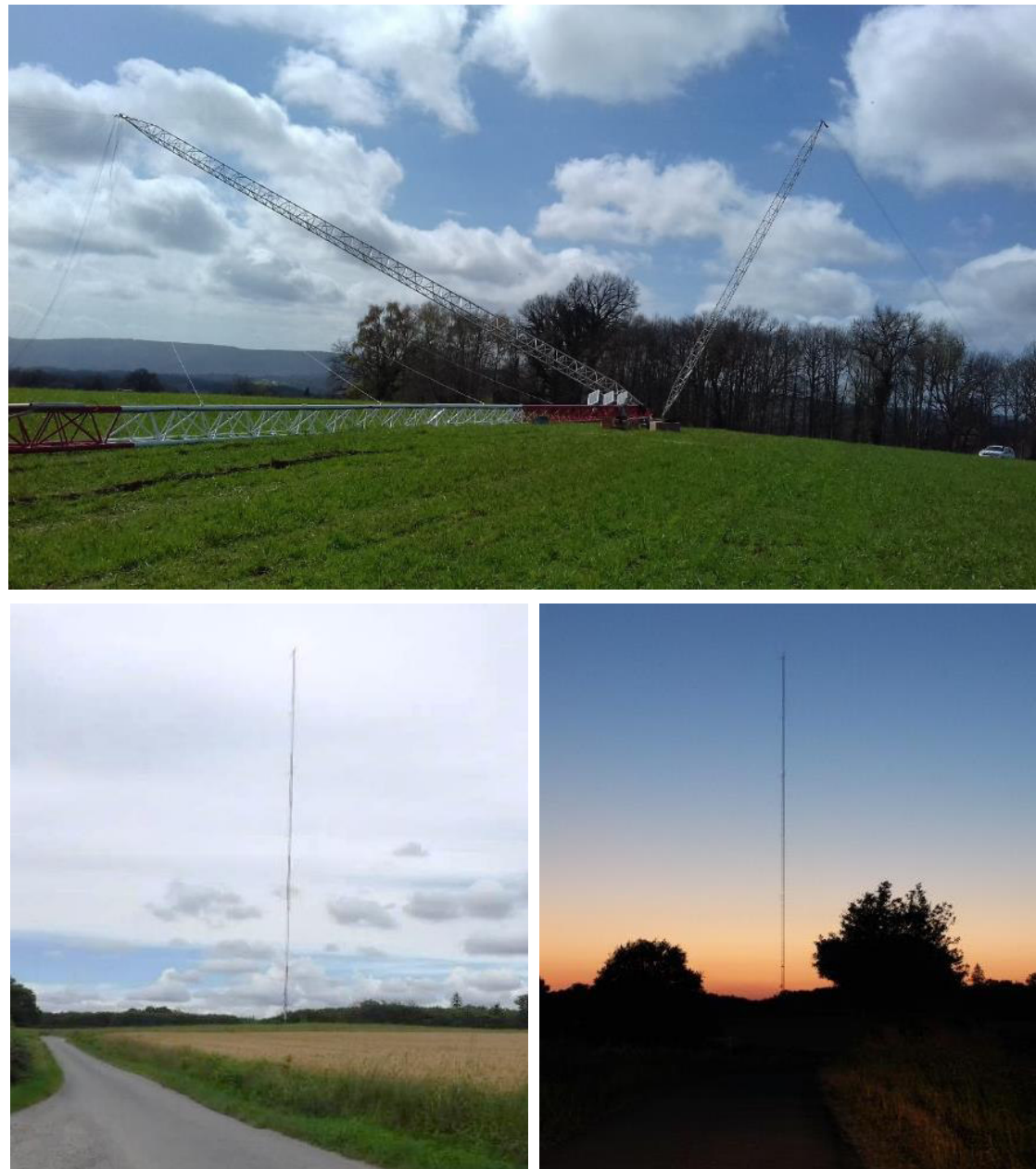
Figure 25 : Mât de mesures anémométriques du projet de Folles (Crédit photo : EOLISE et NCA)
