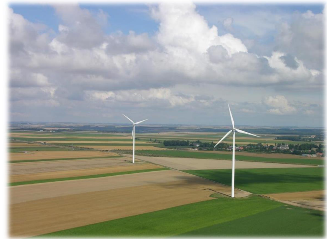
Figure 18 : Photo du parc éolien de Vauvillers
