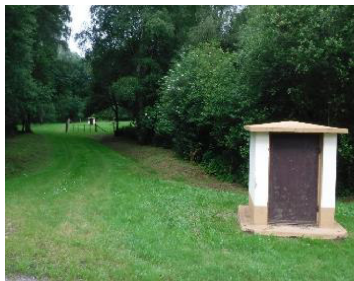
Vue K : Vue depuis la RD63 de la zone de captage
