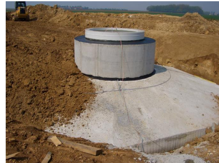
Figure 32 : Remblaiement des fondations (Source : EOLISE et ECOTERA)
