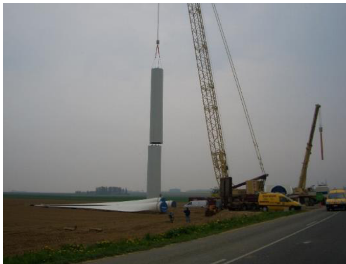
Assemblage des tronçons du mât
