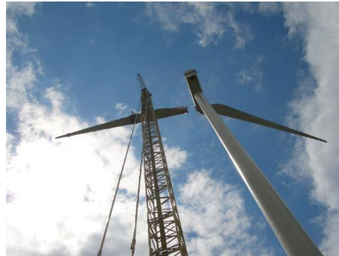
Assemblage des pales
