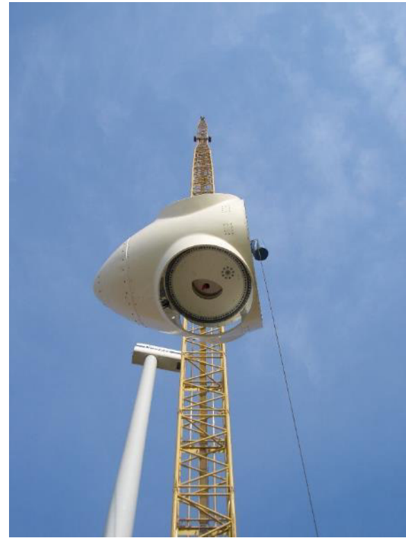
Assemblage du rotor
