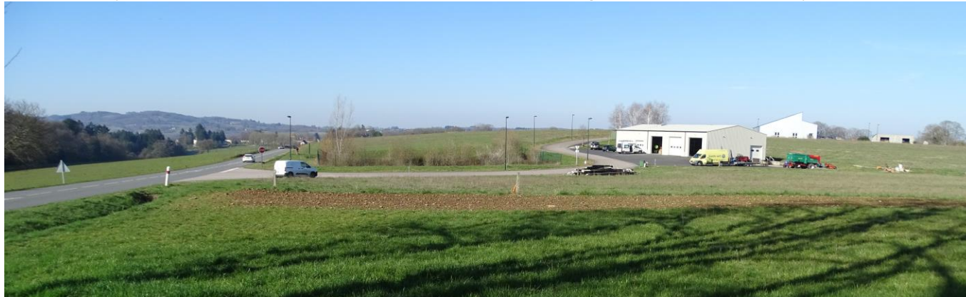
Vue de la partie Est des terrains du projet en direction de l'Ouest (Zone d'Activités Economiques la Croix Lattée avec bâtiments et bassins des eaux usées et eaux pluviales, chemin de la ZAE la Croix Lattée)
