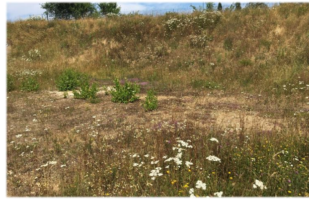
Bassin de rétention d'eau à sec
