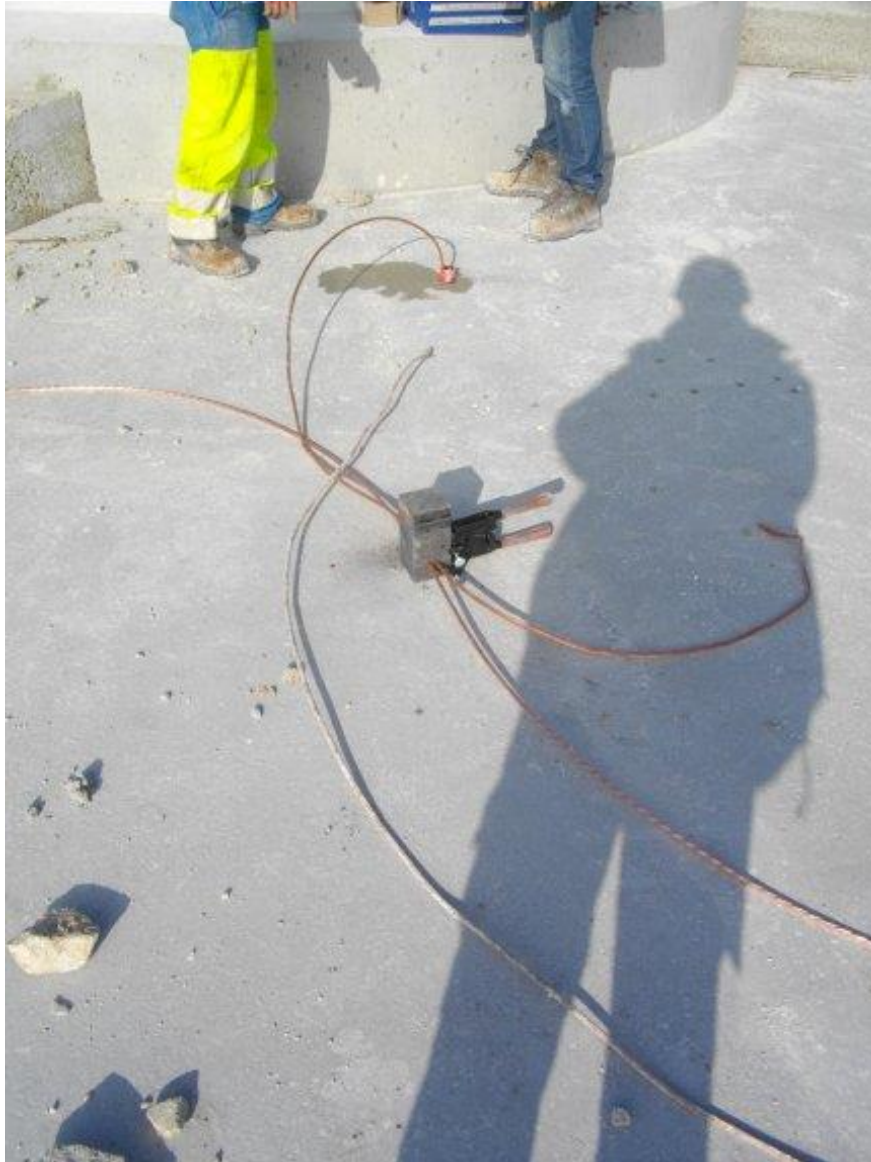
Figure 8 : Interconnexion du réseau de terre
