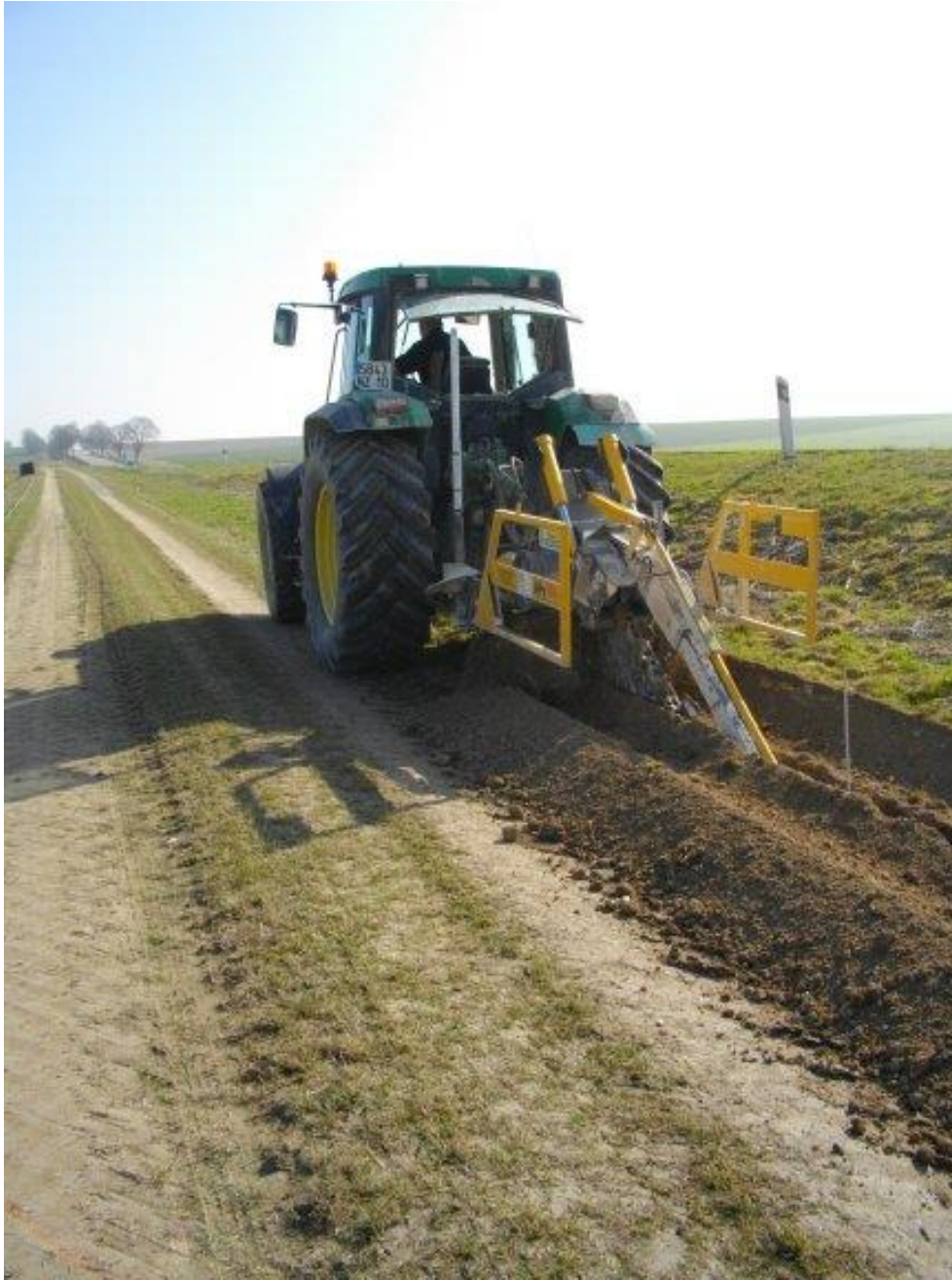
Figure 4 : Ouverture à la trancheuse
