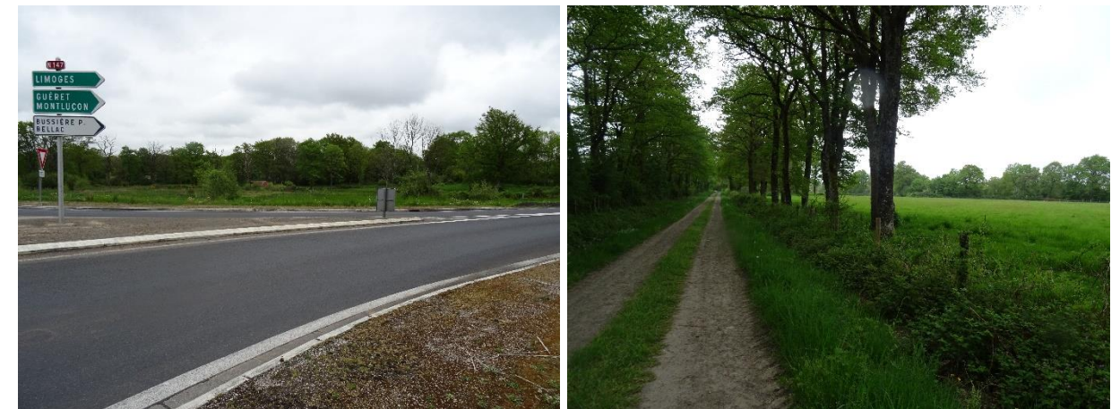
Figure 5 –Vue de la RN147 au droit du carrefour avec la RD10 (à gauche) et du chemin carrossable à l'est (à droite) (Eco-Stratégie, le 15 avril 2018)
