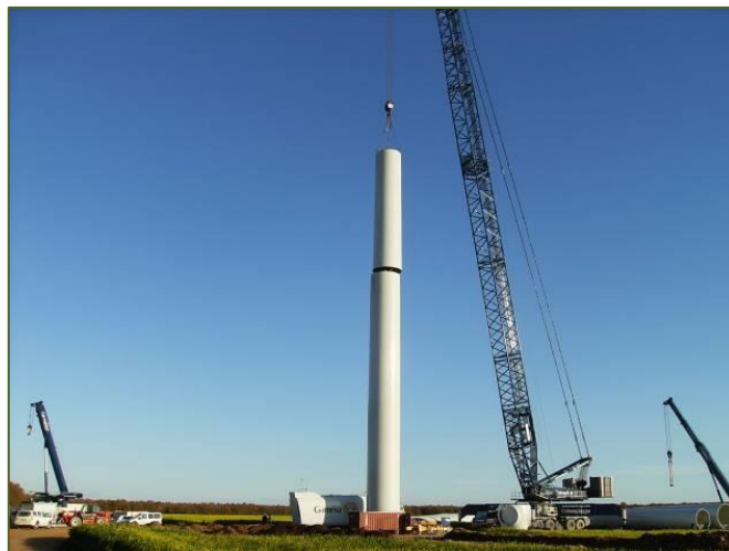
Photographie 6 – Montage des éléments de la tour (source : Siemens Gamesa)
