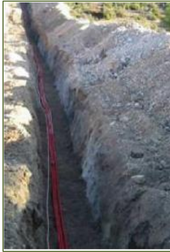
Photographie 10 – Tranchée pour la mise en place des câbles du réseau interne (source : Siemens Gamesa)
