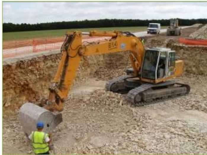
Photographie 2 – Excavation (source : Siemens Gamesa)
