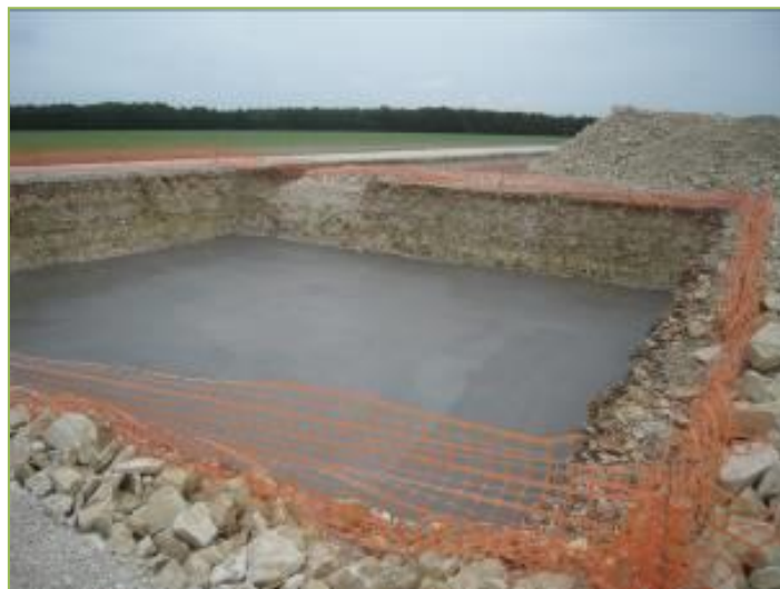
Photographie 3 – Béton de propreté (source : Siemens Gamesa)
