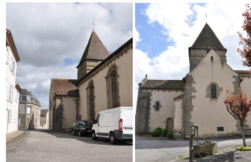
Photographie 67 – Eglise de Bussière (MH. 39) (Source : ECO-STRATEGIE, le 16 avril 2018)
