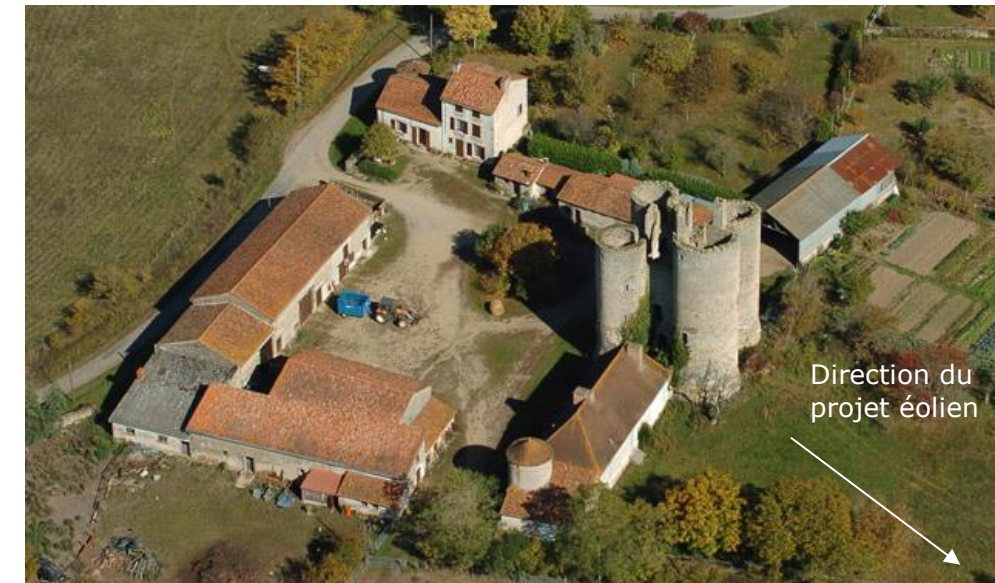
Photographie 32 – Vue aérienne du Donjon de Lenest (ou de Lenet) (Source : photographie issue du site internet communal, saulge.fr)
