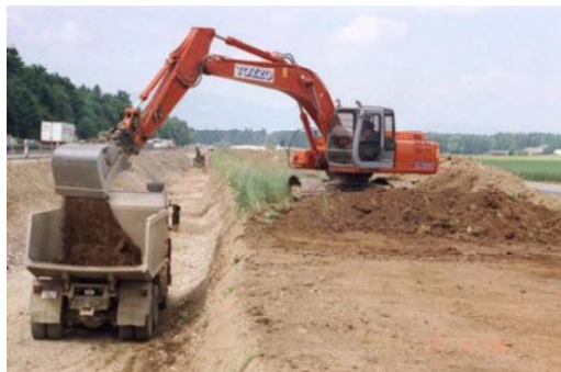
Décapage depuis l'horizon A à l'aide de pelle sur chenilles ; le camion circule sur l'horizon C ; la pelle lisse ne circule pas sur l'horizon B
